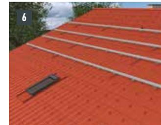
Abbildung 70 • Fertig montiertes Montagesystem (einlagig)
