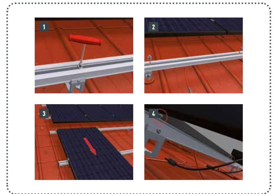
Abbildung 54 • Modulabsturzsicherung
