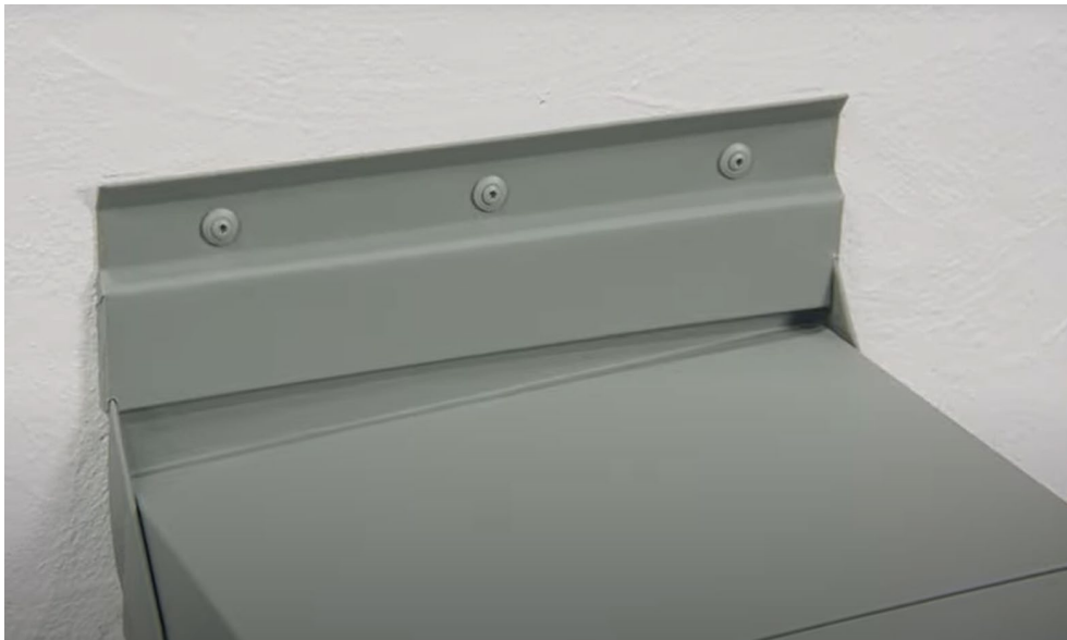
BILD 12 | SEITLICHER ANSCHLUSS DER ATTIKA MIT KITTLEISTE
