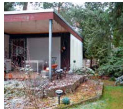
Vor allem die Vorgabe der max. 4,00 m hohen Traufe machte die Aufgabe schwierig, da der bestehende Keller bereits ca. 1,20 m aus dem Gelände herausragte. Die Dachschräge des 45° geneigten Satteldachs begann somit bereits mit der OK FFB des Dachgeschosses.
